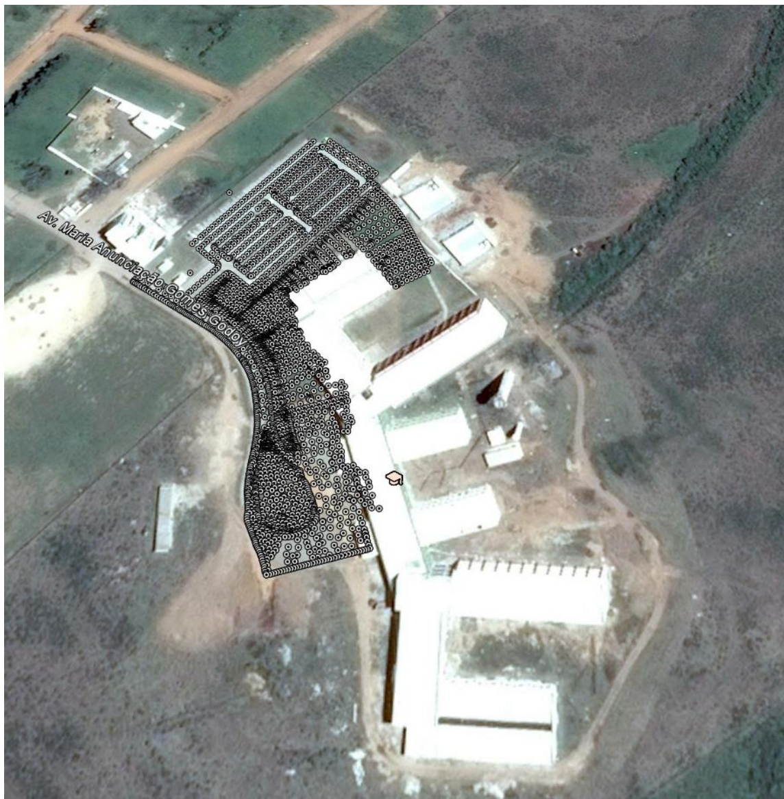
Figura 2 Pontos medidos na área interna do campus Bagé da Unipampa.
